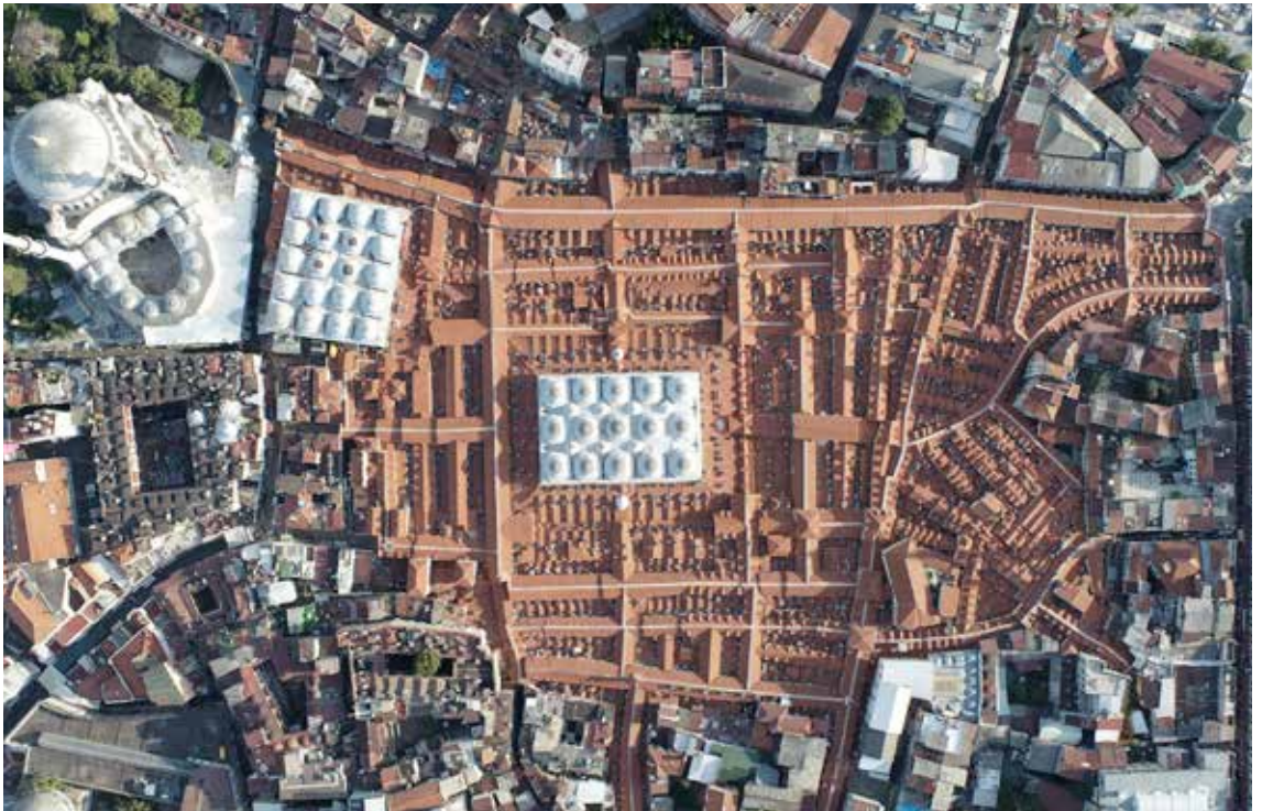
Çatı Restorasyonu Sonrası Kapalıçarşı, 2019
