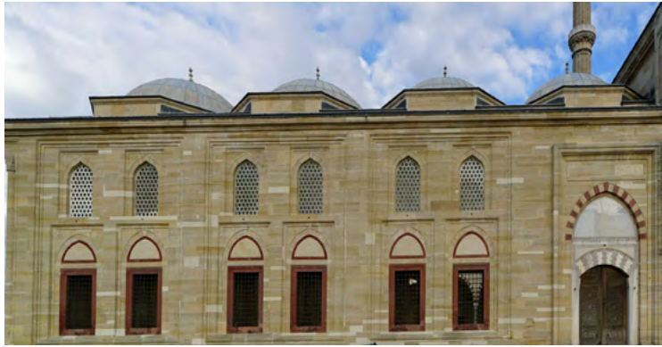
Güneybatı avlu cephesi onarım sonrası
