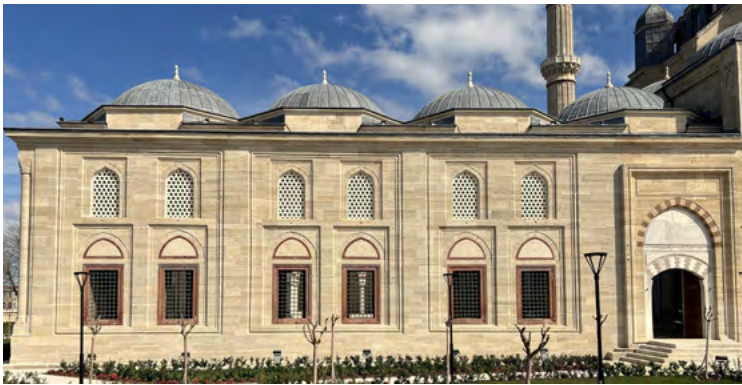
Güneybatı avlu cephesi onarım öncesi
